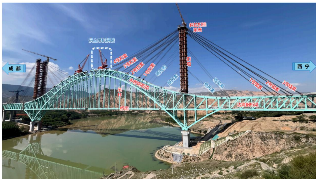
图1 斜拉扣挂系统
