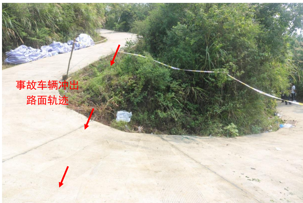
图 6 事故车辆冲出路面处路段图（由北向南拍摄）
